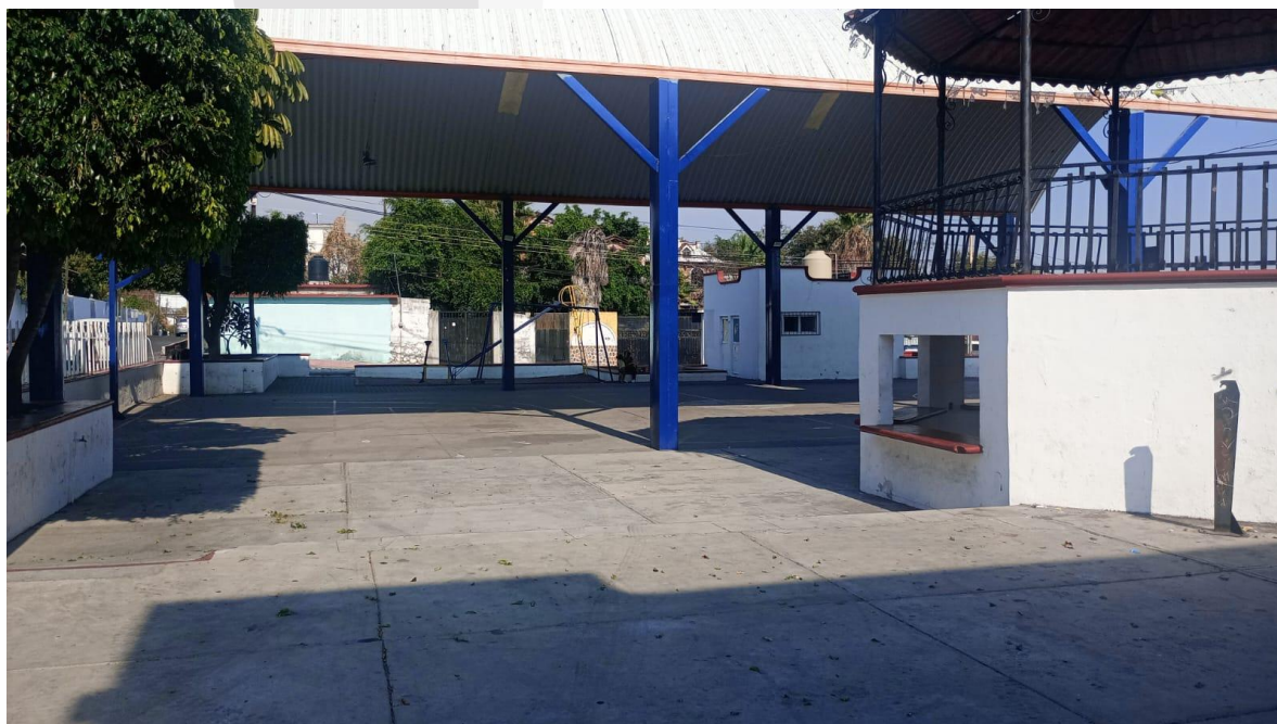
Cancha de usos múltiples de la comunidad de Pueblo Viejo, Temixco Morelos.
