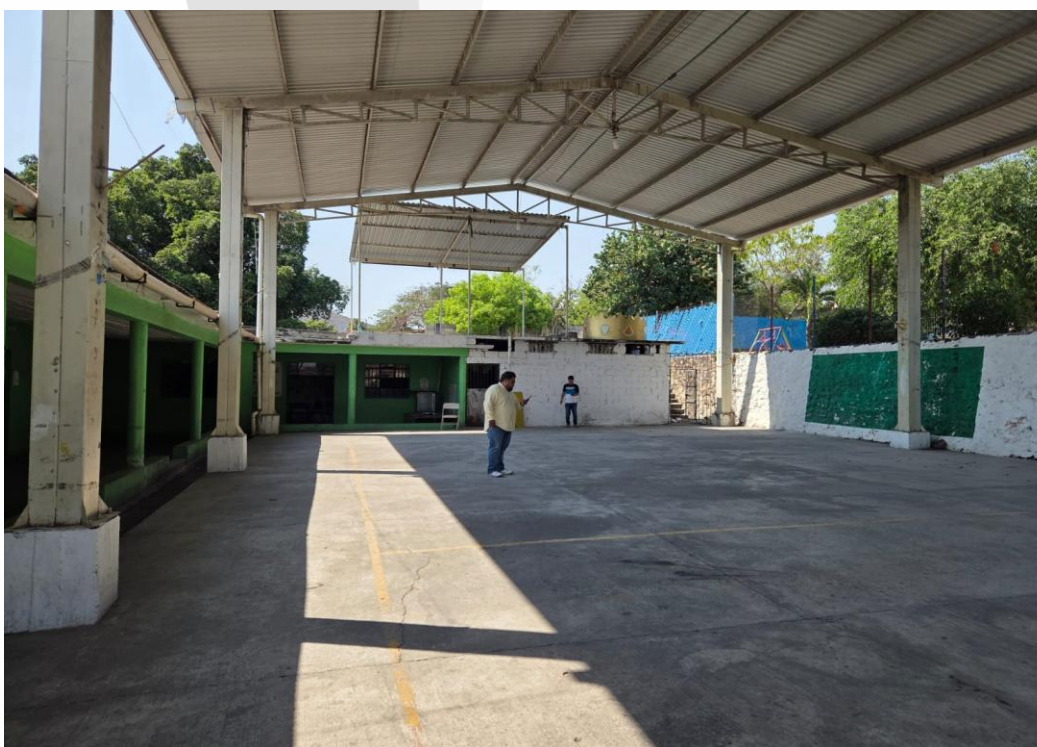
Cancha de la Ayudantía del pueblo de Tetelpa en Zacatepec, Morelos.
